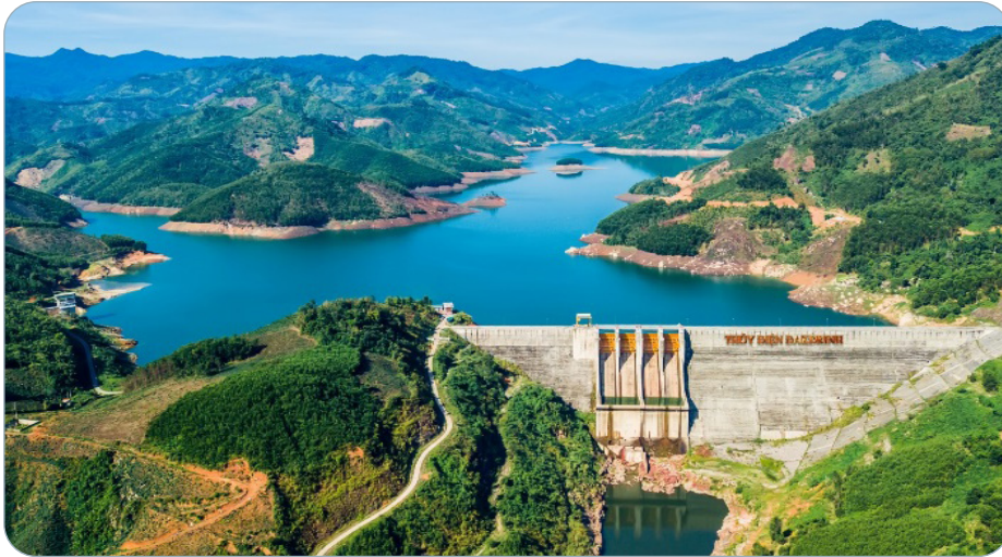
Hình 1.2. Thủy điện Đắk Đring (huyện Sơn Tây)
